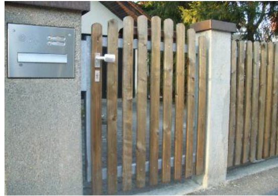
Vierkantlattenzaun gehobelte Latten 65 mm Breit 25 mm stark, braun chromfrei braun kesseldruck imprägniert Kopf schräg Bindestangen 85 mm hoch Breit 55 mm
